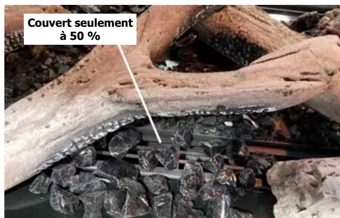
Placement correct du charbon
